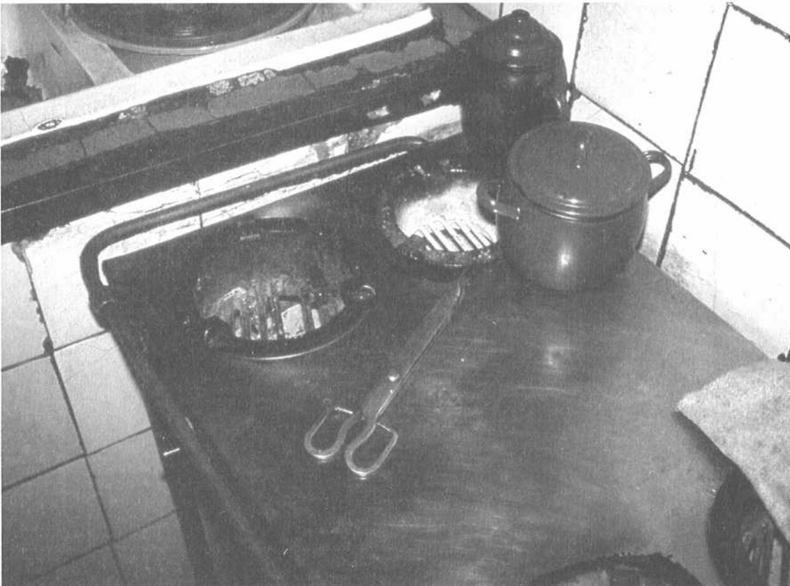
Foto 6. El combustible sigue siendo el carbón, pero el mueble es ya metálico y viene de lejos, gracias al ferrocarril.
