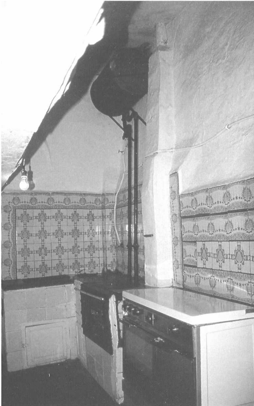
Foto 4. El aprovechamiento del espacio en una antigua chimenea, donde se ha instalado primero una cocina de carbón de mampostería, luego una cocina económica que permite producir agua caliente y por fin la moderna cocina de butano. No se destruye, no se reemplaza: se agrega.
