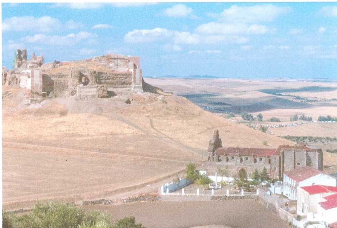
Fortaleza almohade de Montemolín. (En primer término ermita de la Granada).
