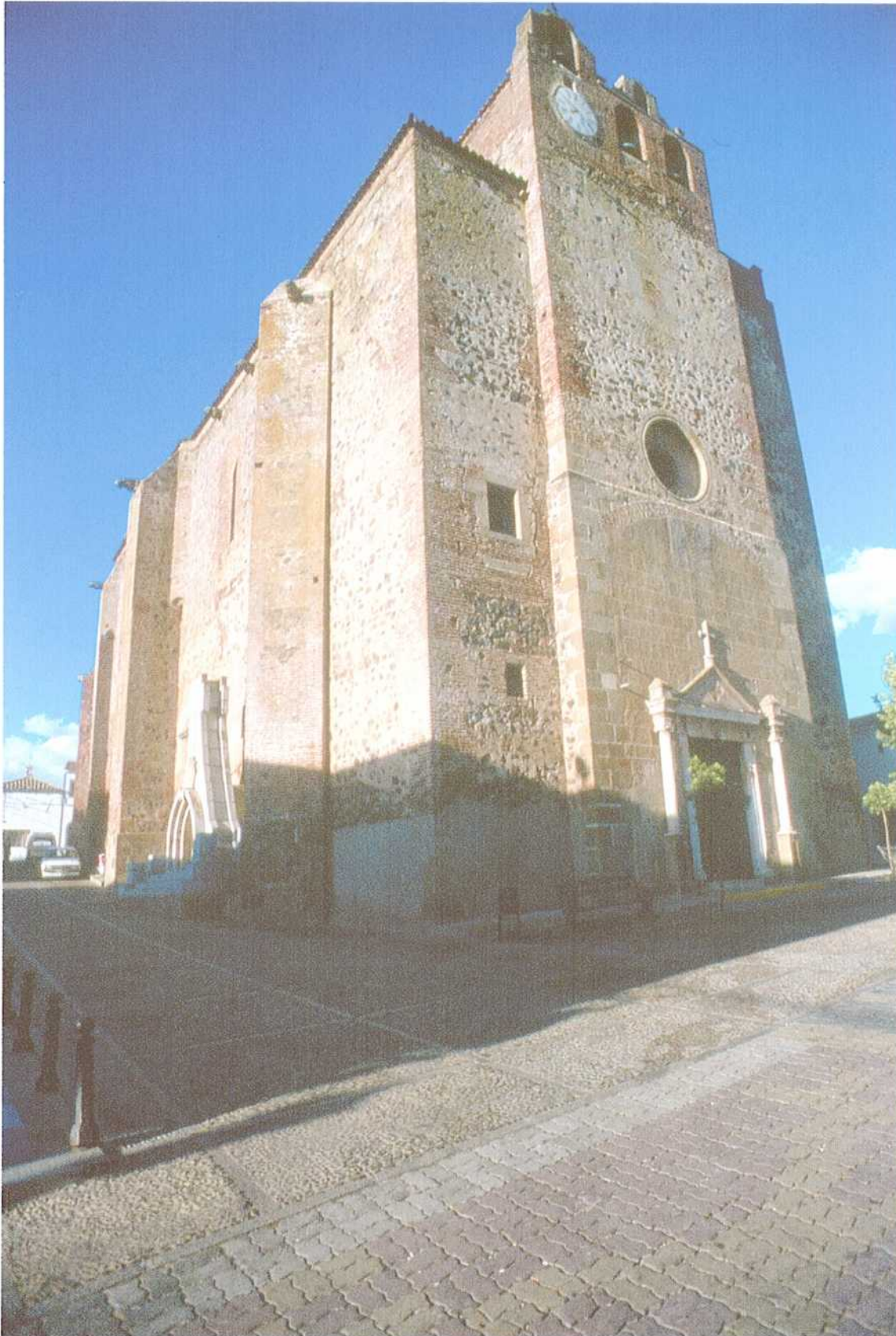
Vista general de la Iglesia de Ntra. Sra. de la Concepción. Montemolín.
